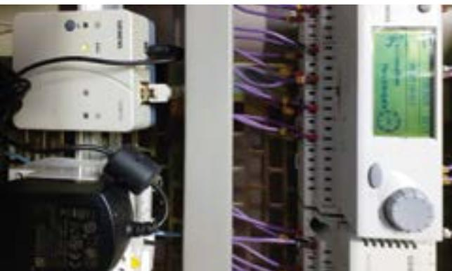
Les mises à l'arrêt et la remise en chauffe peuvent être réalisées à distance. Ce système facilite l'élaboration des diagnostics et accompagne les techniciens lors de leurs interventions sur site. Ils sont prévenus par email d'éventuels défauts de fonctionnement : un gain de temps qui diminue la durée des pannes et donc les coûts.
